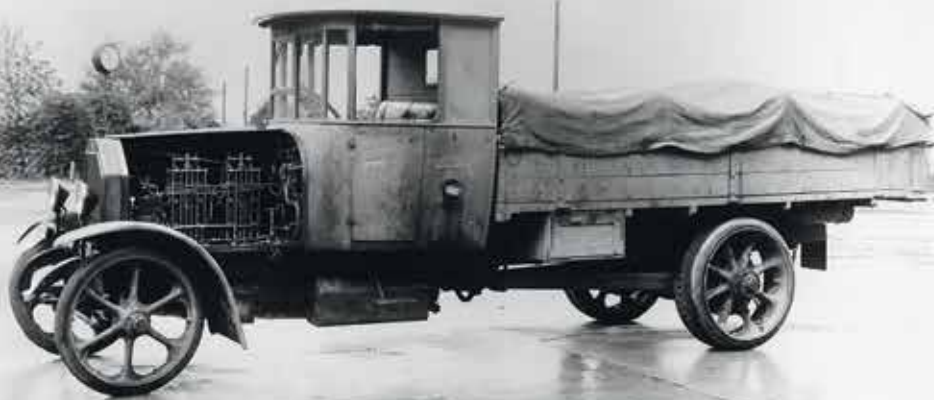
Model DC 3 iz 1923. prvi je kamion s dizelskim motorom koji je razvijao 40 KS te označio početak nove ere u pogonu teretnih vozila
